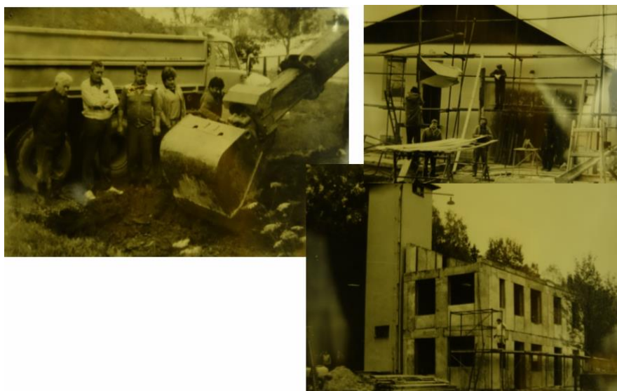
Obr. 8 Přístavba hasičské zbrojnice
